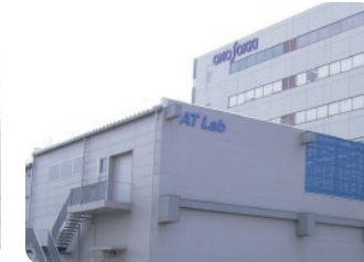
横滨技术中心车辆性能试验室
