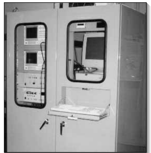
防塵ボックスに収納した本システム
